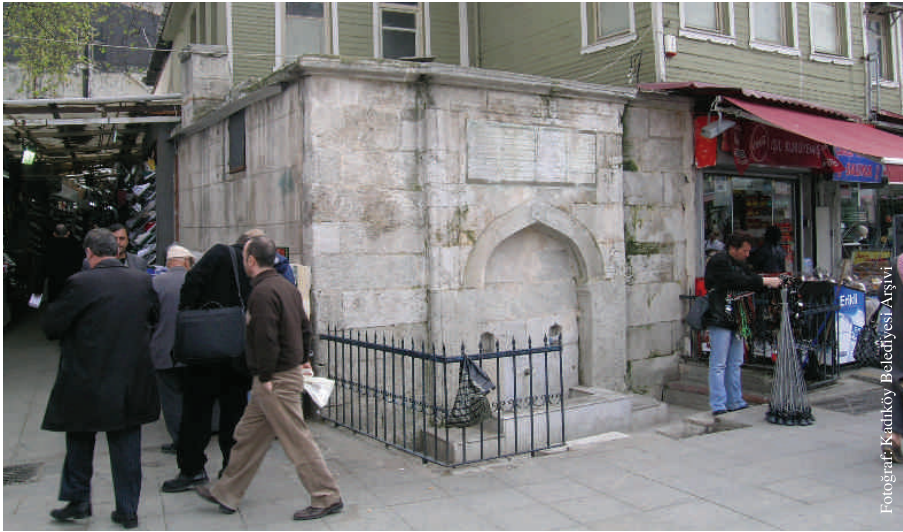
Çe men n rölöve, rest üsyon ve restorasyon projeler hazırlanmadan önce, 2008 yılında çek lm b r foto rafı.
